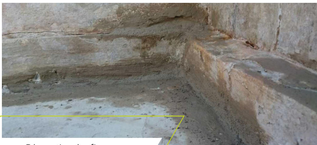
Réparation des fissures
