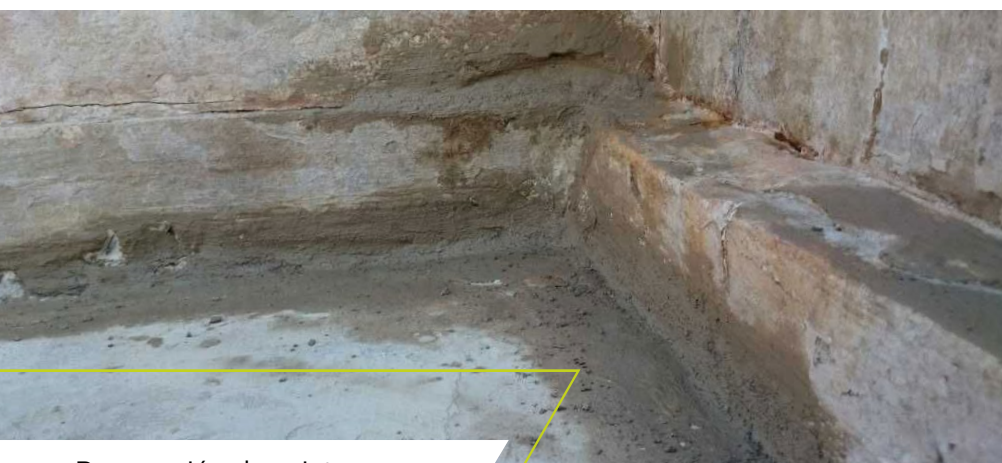
Reparación de grietas
