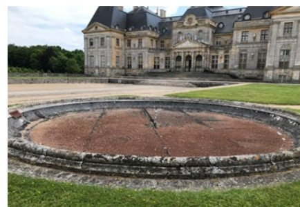
ANTES DE LAS OBRAS
